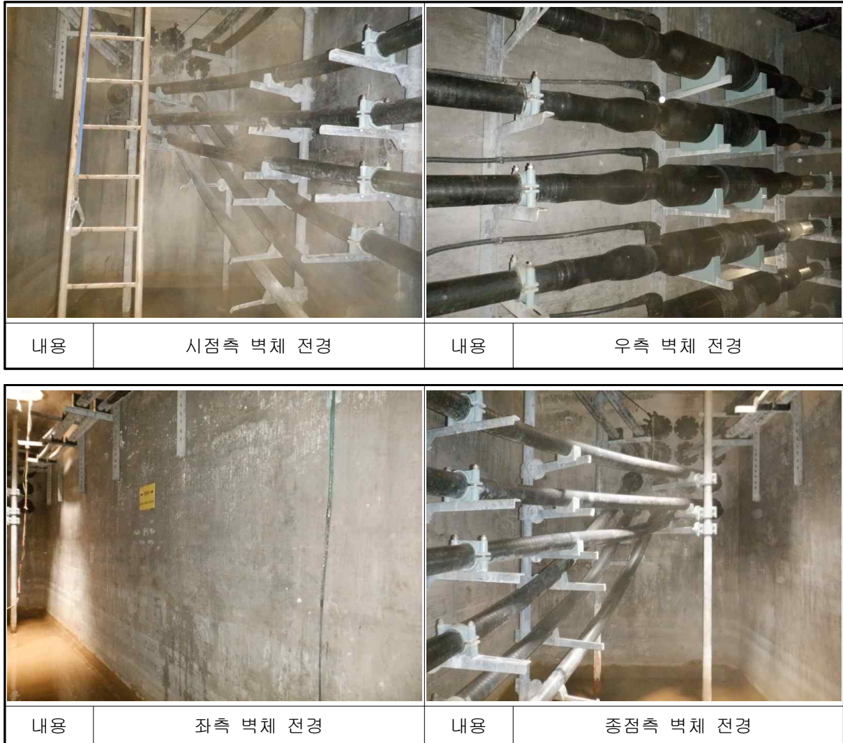
[사진 7.53] 운정~덕이#5 전경
