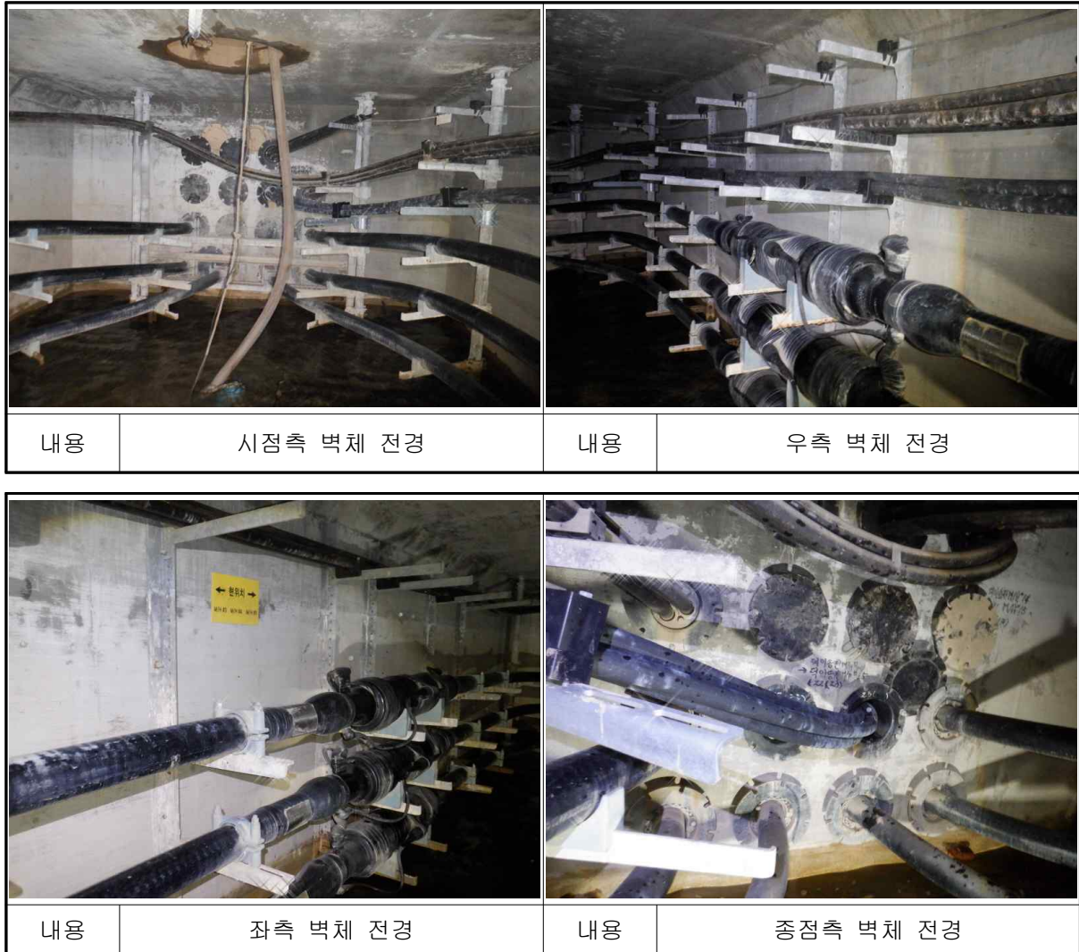
[사진 7.13] 문발~운정#4 전경
