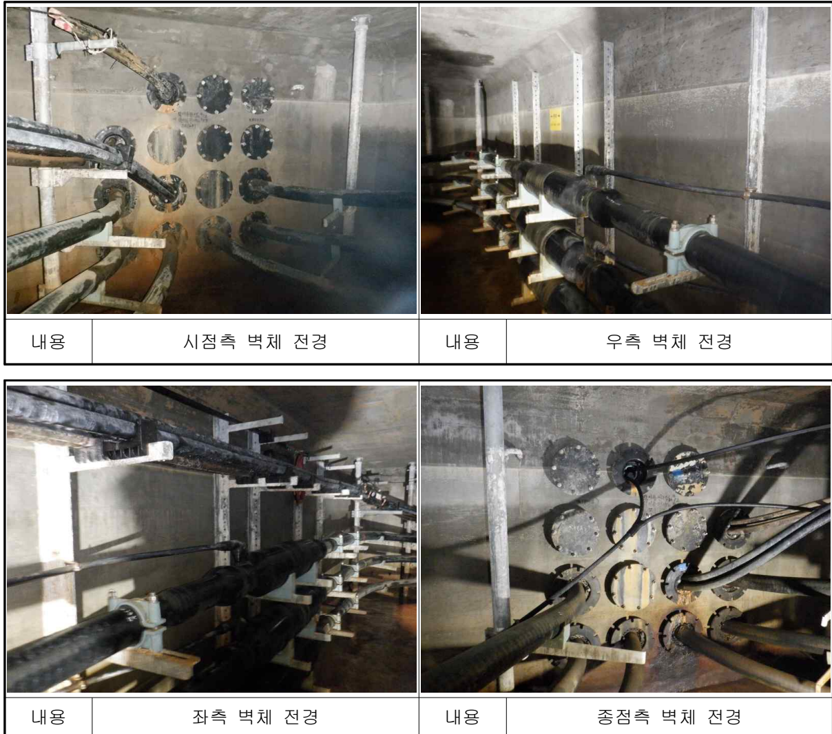
[사진 7.21] 문발~운정#6 전경
