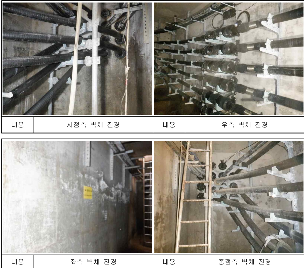
[사진 7.45] 운정~덕이#3 전경
