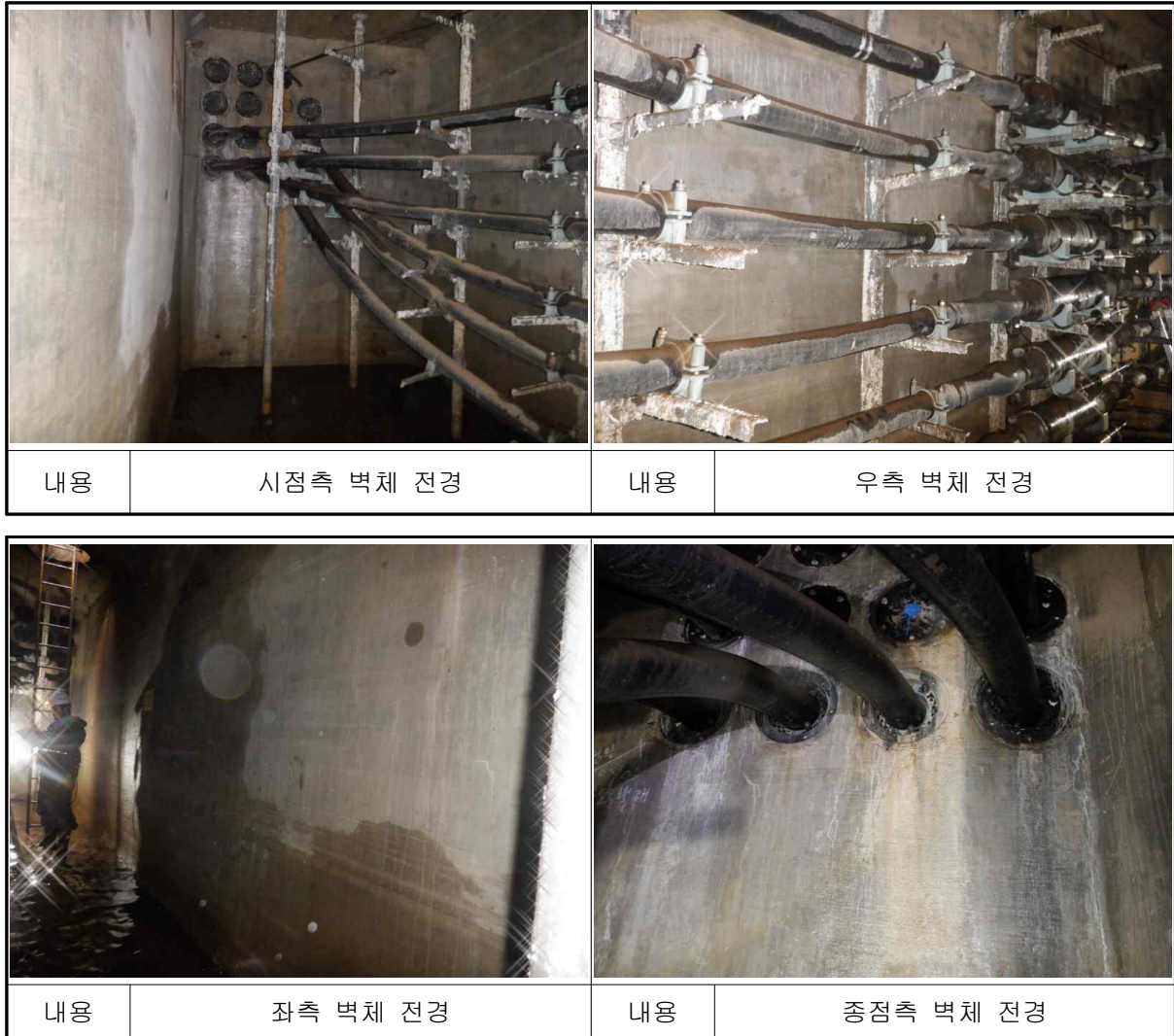
[사진 7.5] 문발~운정 #2 전경
