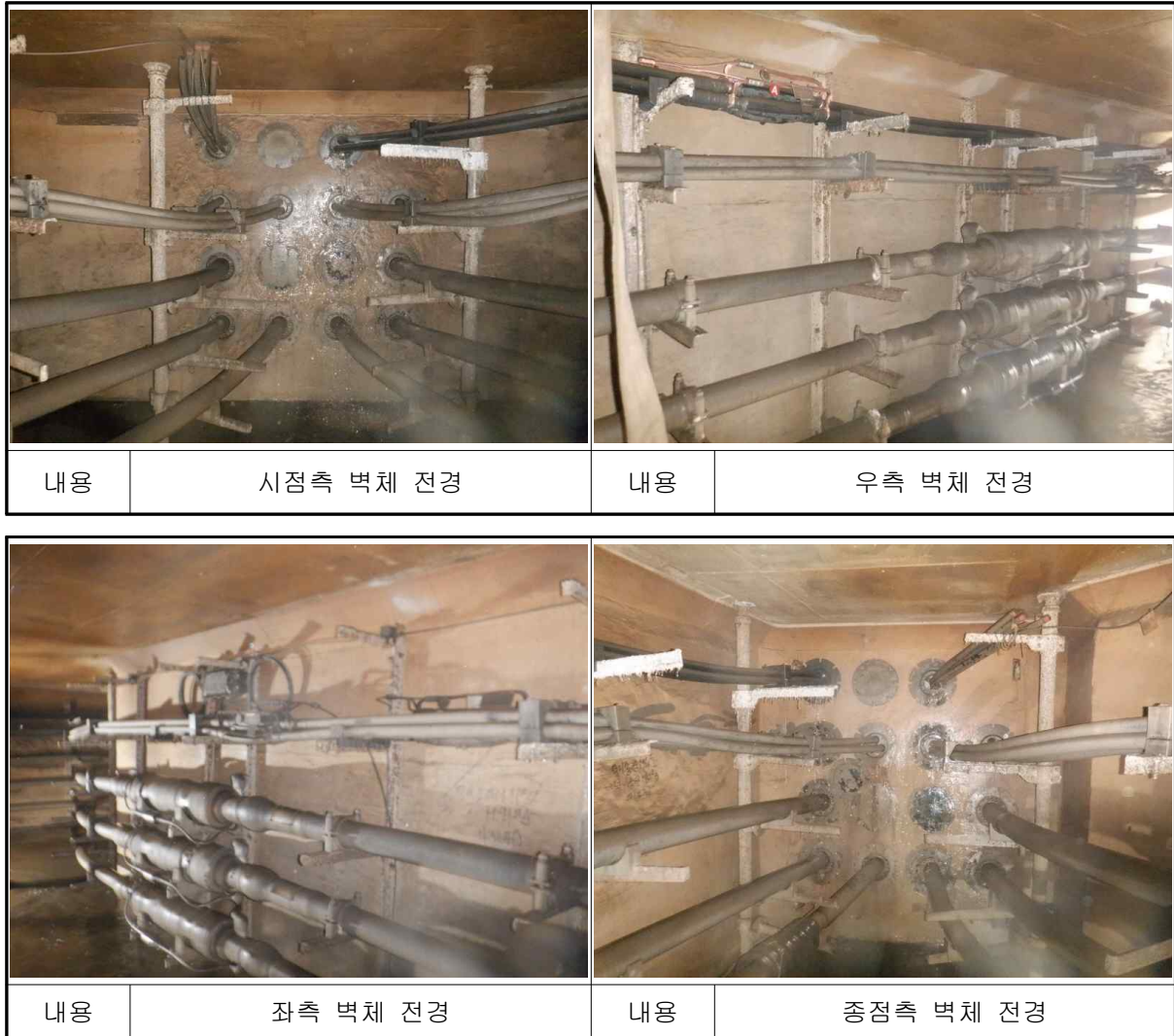
[사진 7.61] 운정~덕이#7 전경
