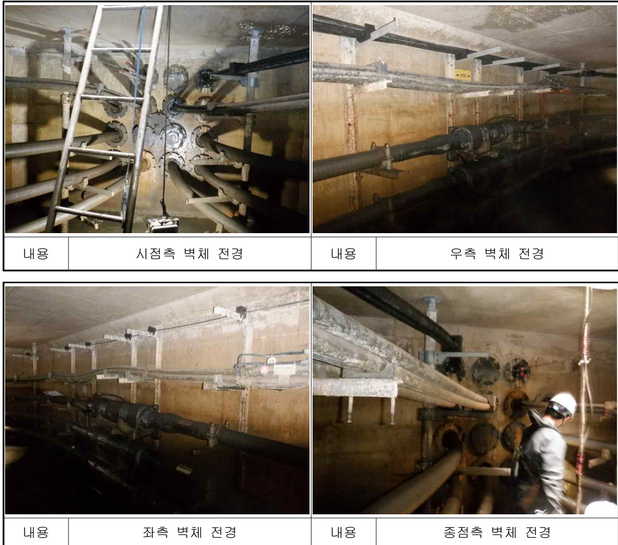
[사진 7.69] 운정~덕이#9 전경
