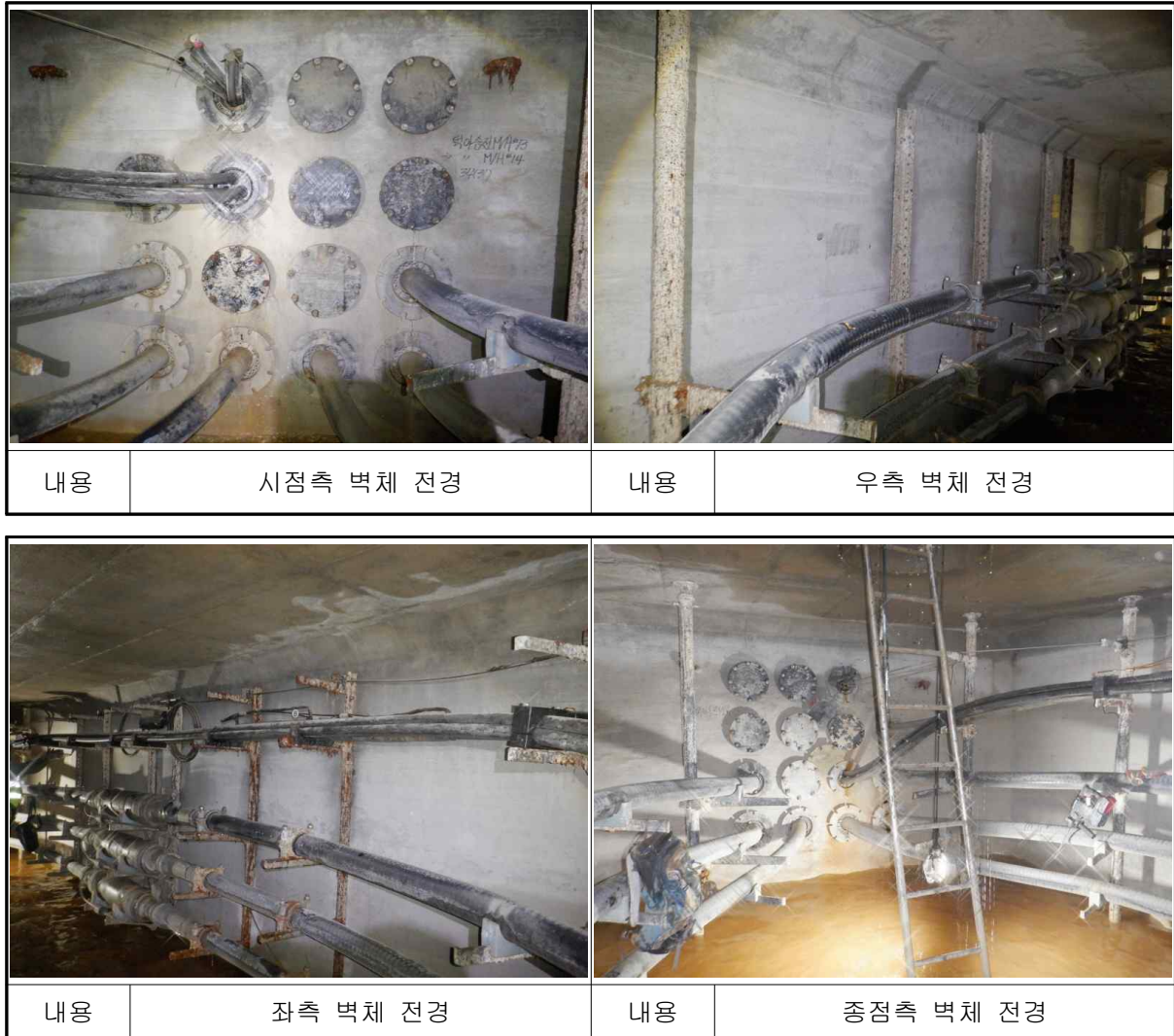
[사진 7.17] 문발~운정#3 전경
