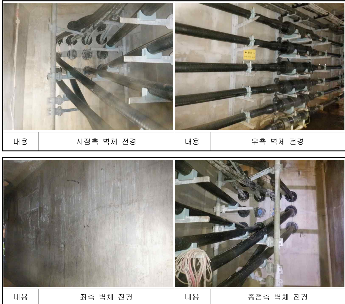
[사진 7.57] 문발~운정#13 전경
