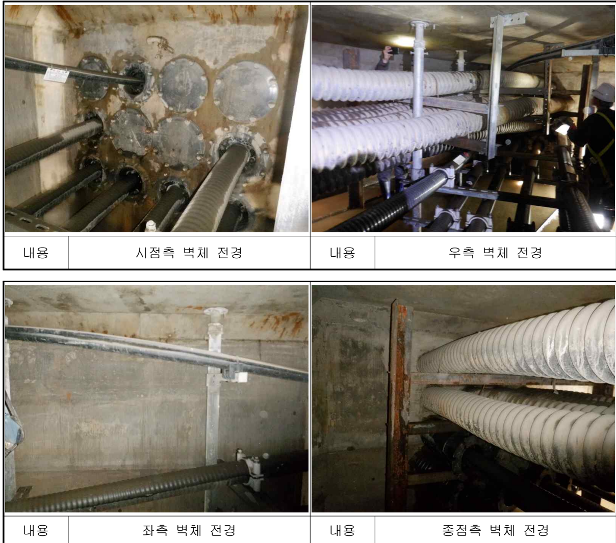
[사진 7.33] 문발~운정#0-1 전경
