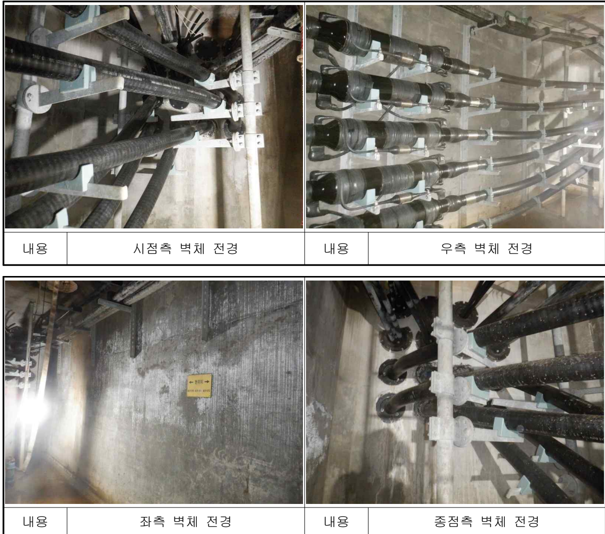
[사진 7.49] 운정~덕이#4 전경
