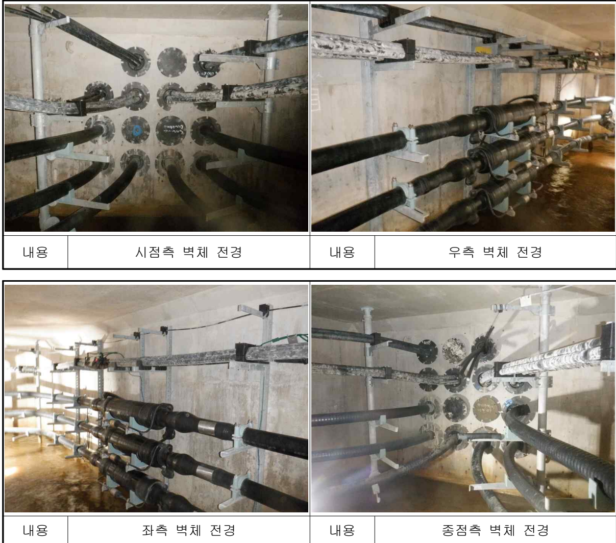
[사진 7.73] 운정~덕이#10 전경
