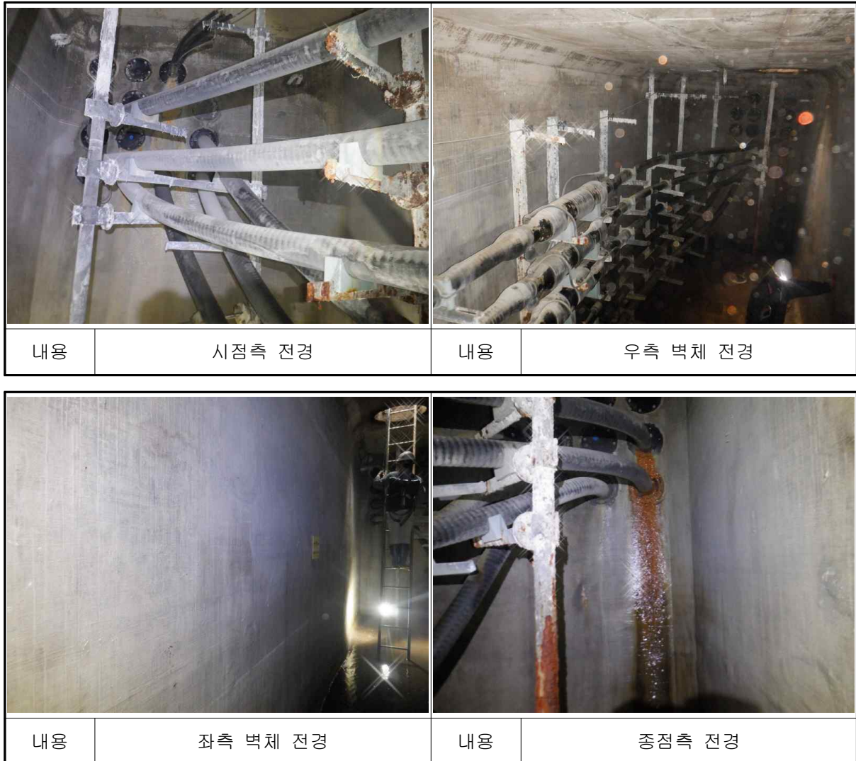
[사진 7.1] 문발~운정 #1 전경
