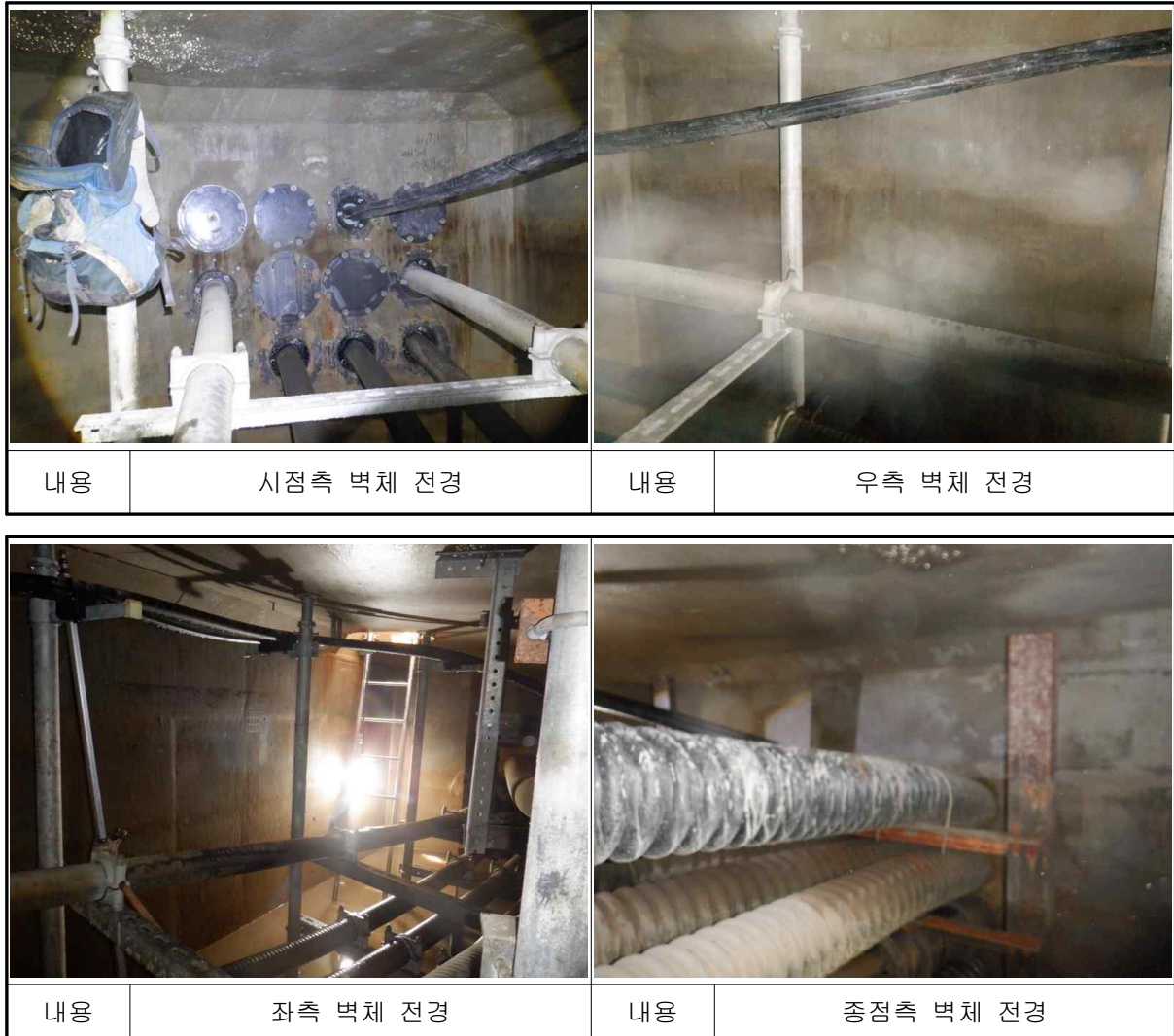
[사진 7.29] 문발~운정#6 전경
